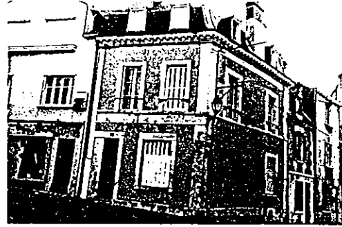
2 rue des Pucelles (430) (6) 1 rue des Pucelles (429)
