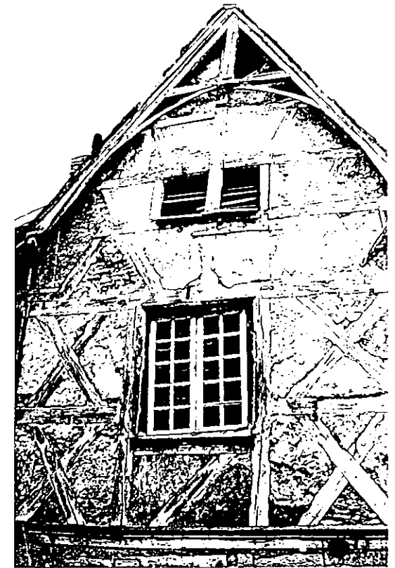
26 rue des Bouchers
